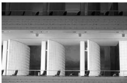
FIGURE 1.4 – Détail de portes entre la salle principale et la chambre de réverbération au niveau d'un balcon, dans la salle du KKL à Lucerne en Suisse.
