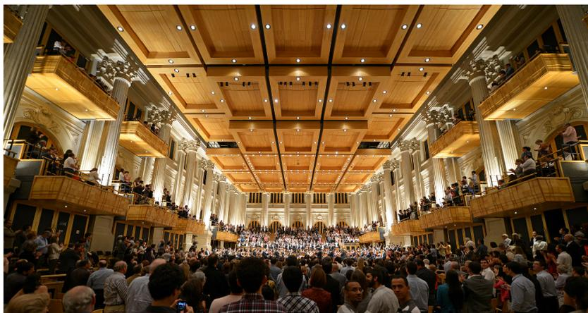
FIGURE 1.2 – Vue de la Sala à São Paulo, Brésil. Les unités qui composent le plafond sont mobiles en hauteur. Inauguration : 1999. Acousticiens : Artec et Acoustica & Sonica.
